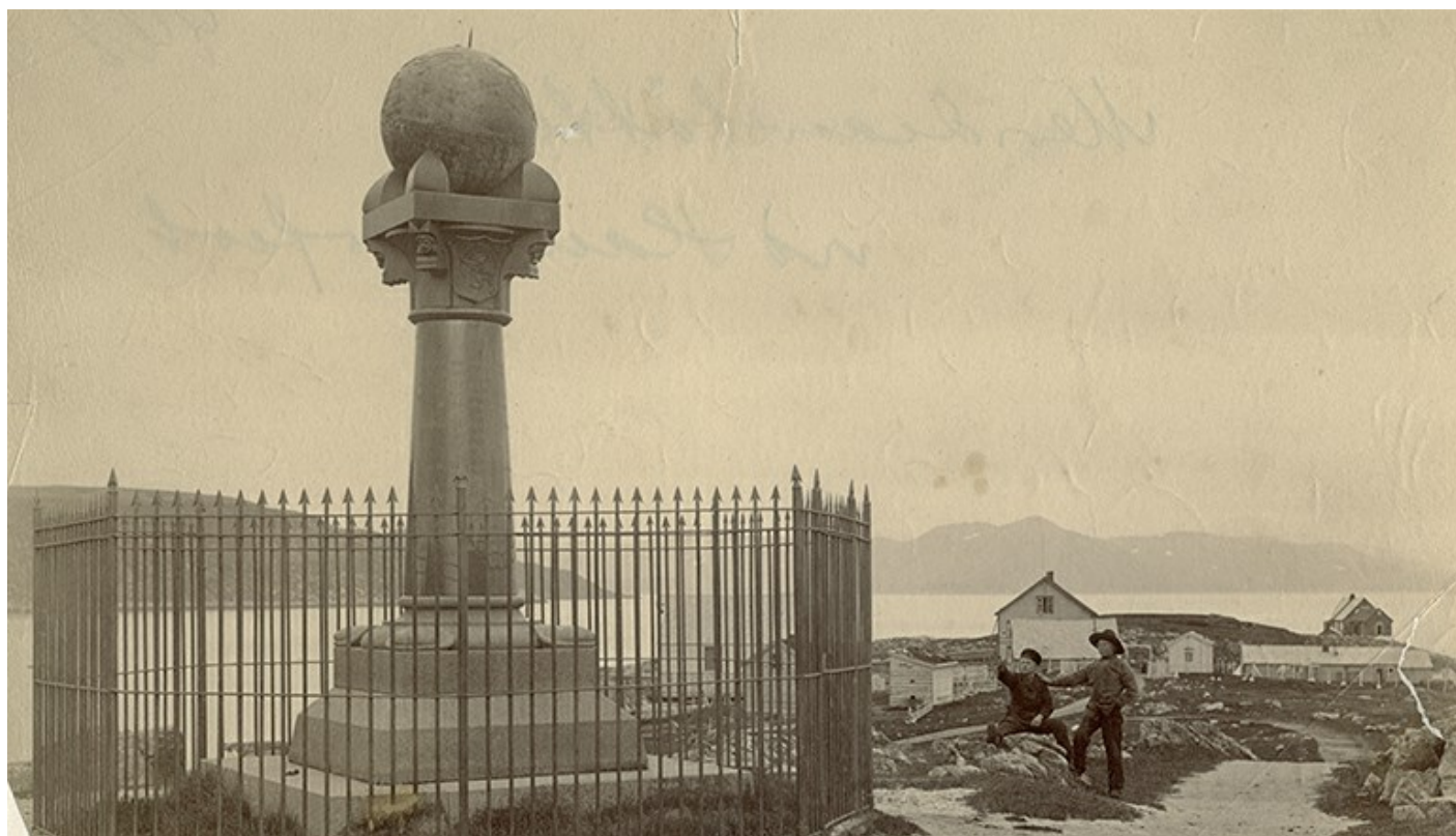
Struvemeridianen / Struves meridianbue går fra Hammerfest i nord til Svartehavet. Støtten på Fuglenes i Hammerfest er oppført i 1854, tegnet av W. V. Hanno. Foto: Ukjent, Riksantikvaren
