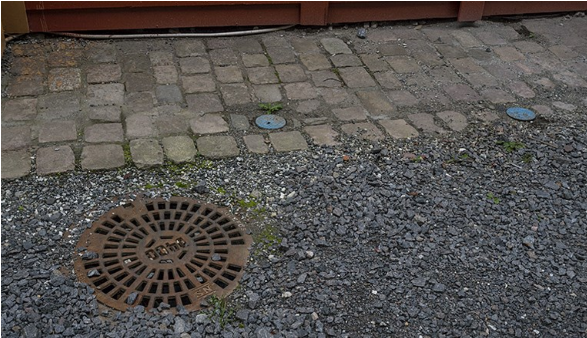
Miljøbrønner for måling av grunnvannstand og vannkvalitet. Foto: Lene Buskoven, Riksantikvaren
