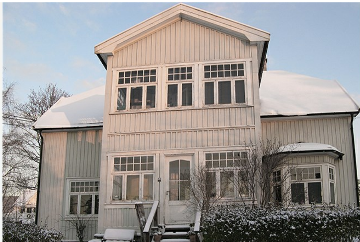
Utbedring av gamle vinduer i stedet for å skifte dem ut med nye, er et godt energisparingstiltak for verneverdige bygninger. Foto: Marte Boro, Riksantikvaren
