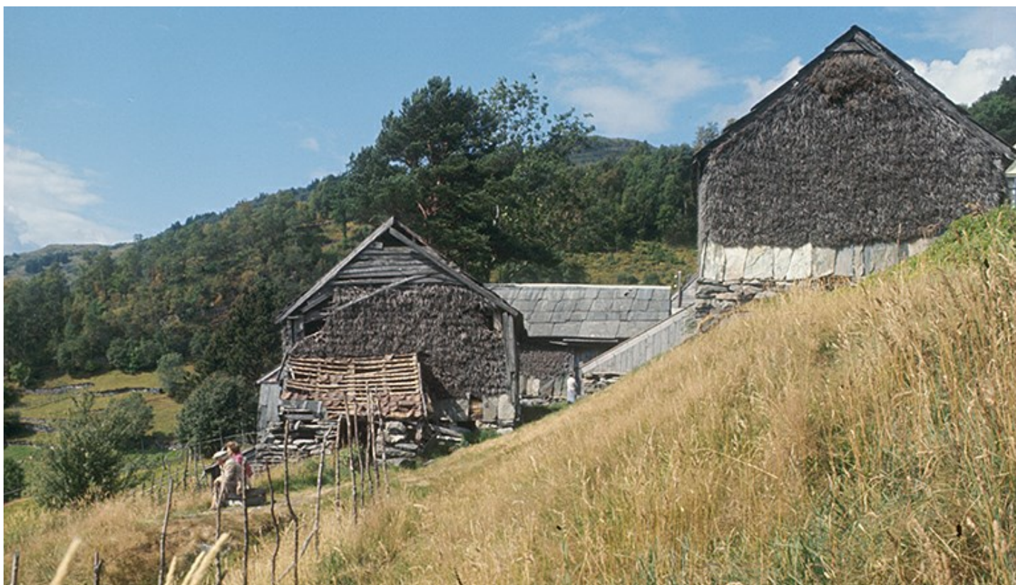
Brakekledning ga bygningane god utluffing for korn og høy. Foto: Ukjent, Riksantikvaren
