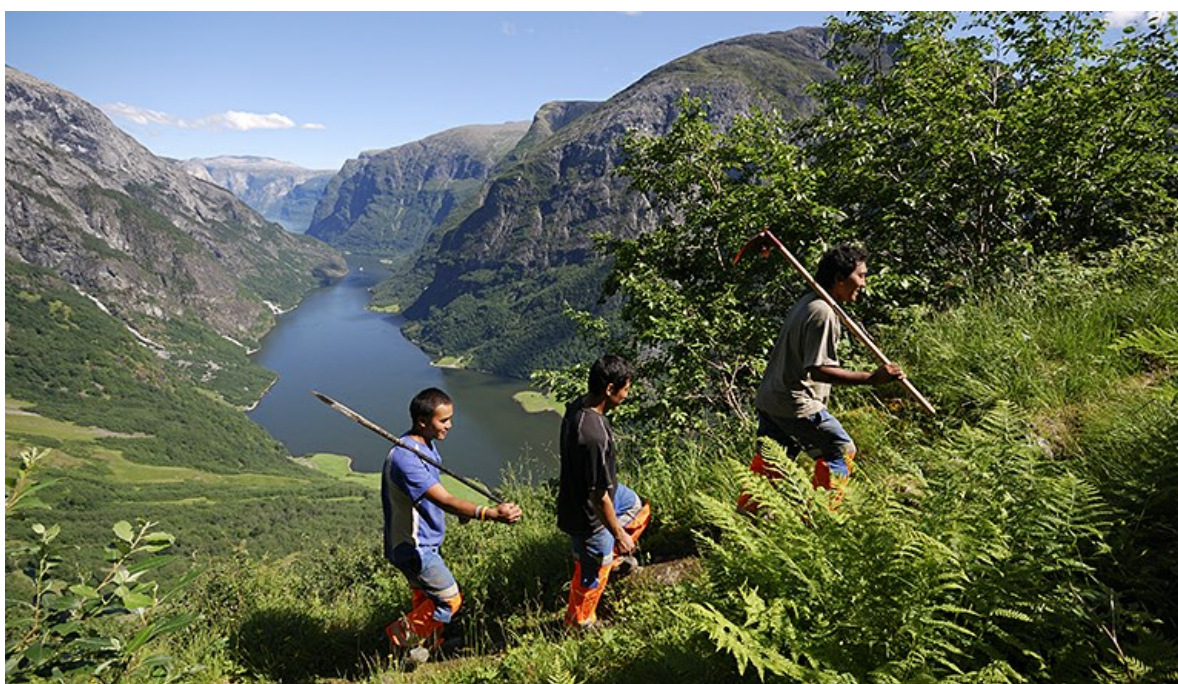
Sherpaer fra Nepal i arbeid med å bygge opp den gamle stølsveien i Nærøyfjorden. Foto: Marit Bendz
